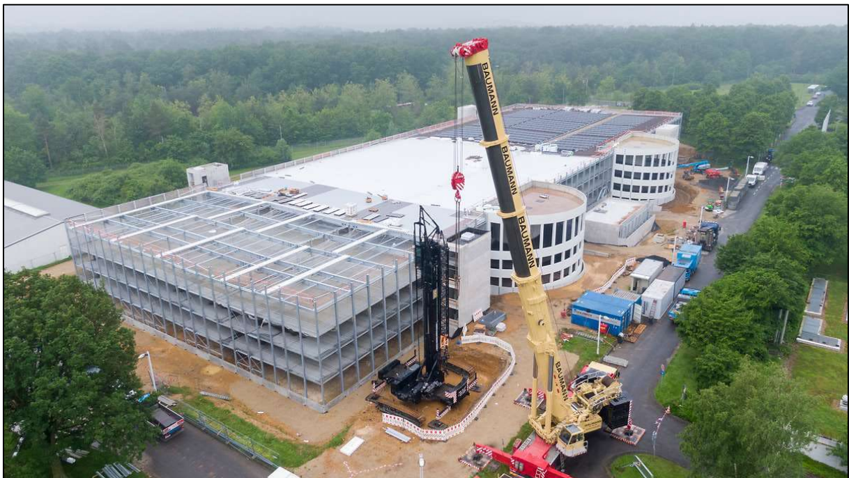
Baumaßnahme auf der Hardthöhe in Bonn Bundeswehr/Torsten Hemmersbach
