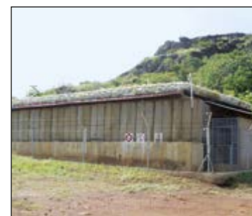
Abb. 1: Vororterkundung der Munitionslagerstätte im Mali
