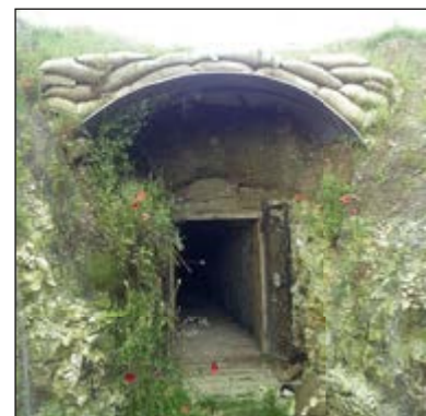
Abb. 1: Eingangsbereich eines Minierstollens bei La Boisselle, Frankreich – ein ideales Messobjekt
