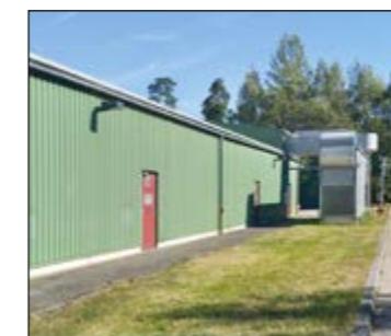
Abb. 3: Vororterkundung Munitionsarbeitshaus Köppern
